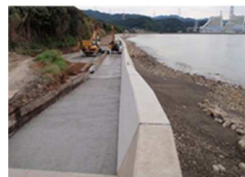
護岸ブロック背面裏込め
