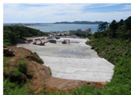
宅地造成盛土への適用事例
