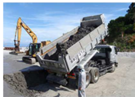
現場荷降ろし
