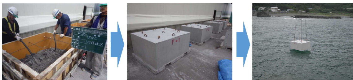
図 3-1 人工藻場ブロック製作から沈設の様子
