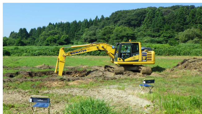
図1 地域建設業協会による試掘
