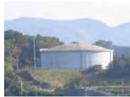
国営事業で整備された調整水槽
