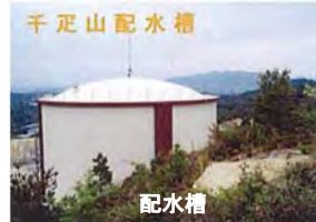
千疋山配水槽
