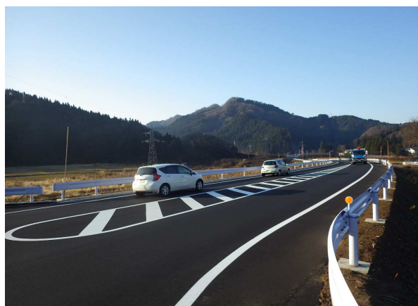
国道285号 五城目町富津内 中津又道路 (平成27年11月6日供用)
