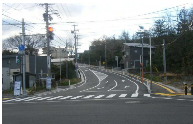
完成(平成27年12月10日)
