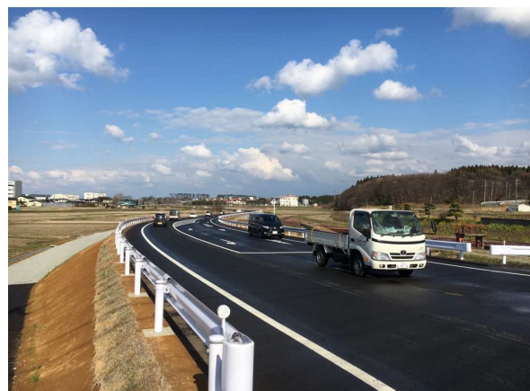
一般県道 富根能代線 能代市朴瀬～向能代 真壁地バイパス (平成27年12月18日供用)
