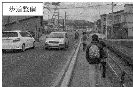
大曲横手線 静町工区（横手市）
