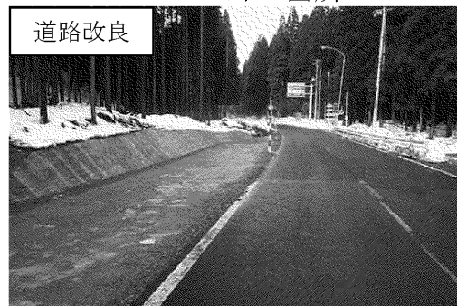
国道105号 草峠工区（仙北市）
