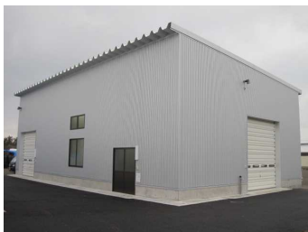
TMRセンター全景
