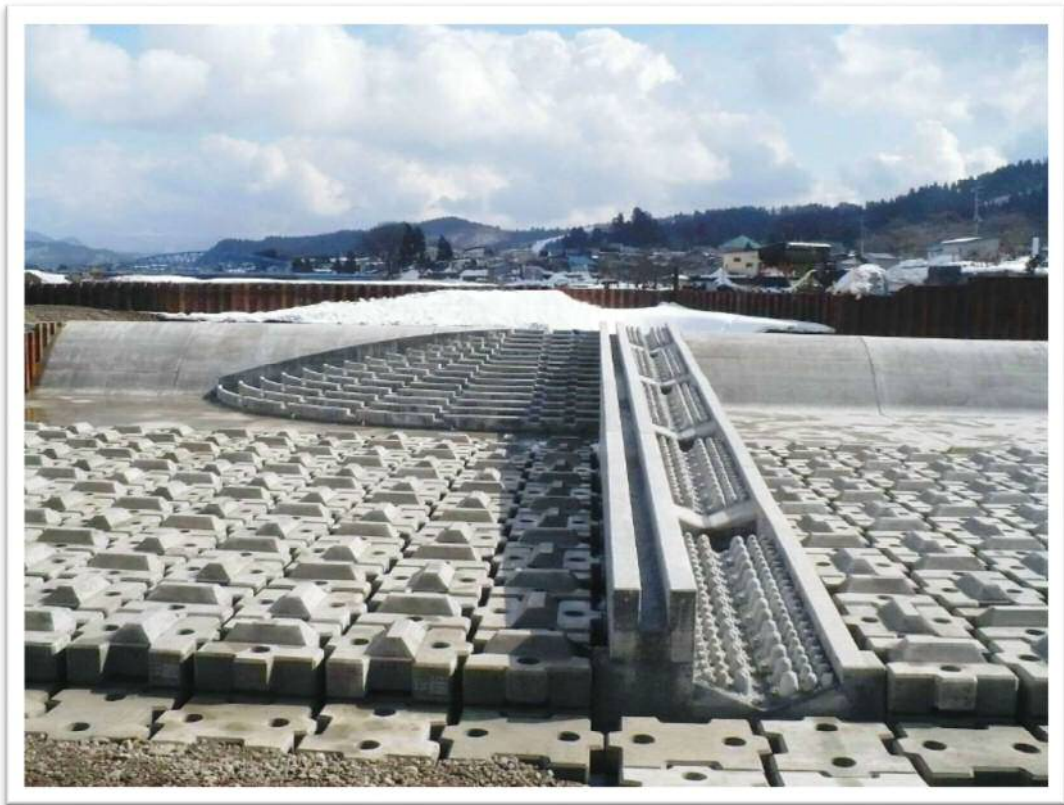
平成 19 年阿仁川豪雨災害で被災した本城頭首工を完全復旧 (農業用施設災害復旧事業 御嶽地区)
