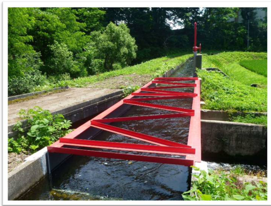
水路の更新整備による農業用水の安定供給 (戦略作物生産拡大基盤整備促進事業 合川地区)
