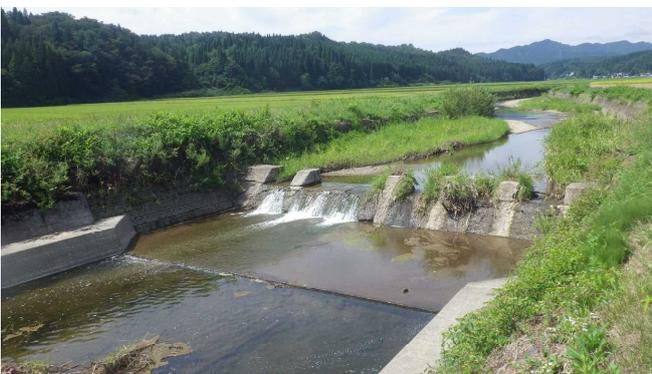
写真2 遡上不能な河川工作物 (床固工)
