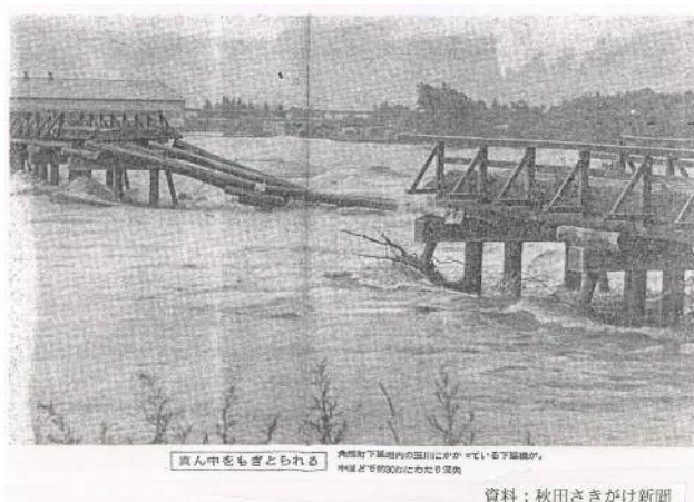
写真5 昭和47年7月洪水被害の様子
