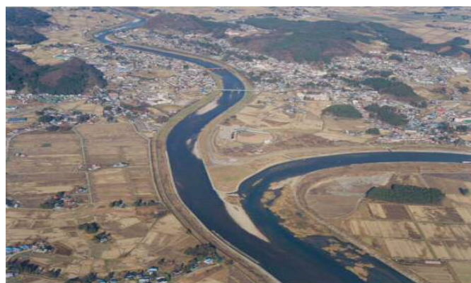
写真2 玉川と桧木内川との合流点の改修状況
