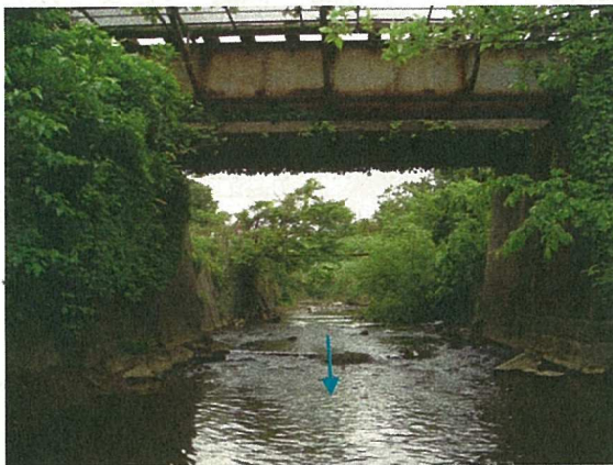
写真 1-6 JR 羽越本線鉄橋
