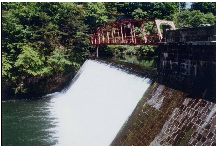
写真 1-3 旧藤倉水源地堰堤
