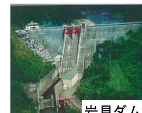
岩見ダム状況写真
