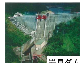
岩見ダム状況写真
