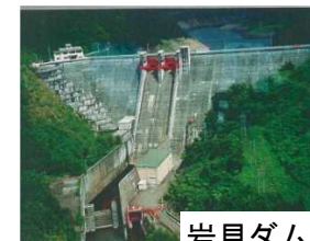
岩見ダム状況写真
