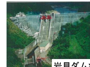
岩見ダム状況写真
