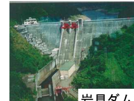
岩見ダム状況写真
