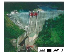
岩見ダム状況写真
