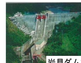
岩見ダム状況写真
