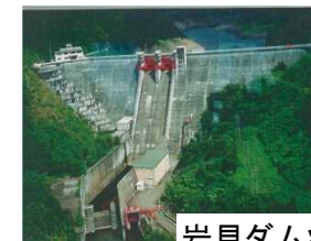
岩見ダム状況写真
