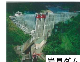
岩見ダム状況写真
