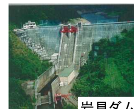
岩見ダム状況写真
