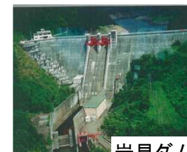
岩見ダム状況写真
