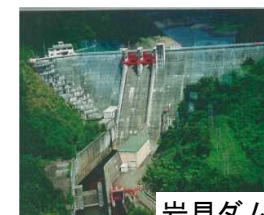
岩見ダム状況写真
