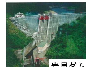
岩見ダム状況写真
