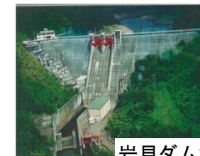
岩見ダム状況写真
