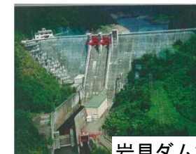
岩見ダム状況写真
