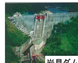
岩見ダム状況写真
