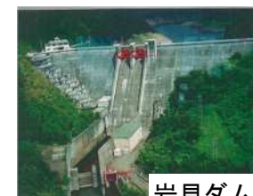
岩見ダム状況写真
