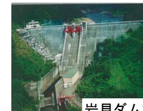
岩見ダム状況写真
