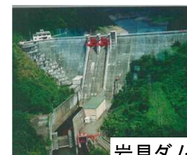
岩見ダム状況写真
