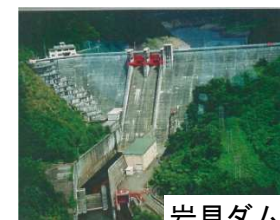
岩見ダム状況写真
