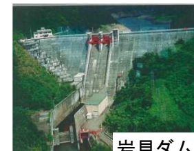
岩見ダム状況写真
