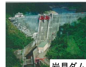
岩見ダム状況写真
