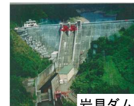
岩見ダム状況写真
