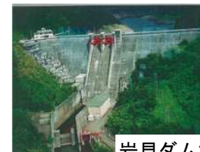
岩見ダム状況写真
