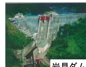
岩見ダム状況写真
