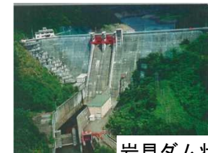
岩見ダム状況写真
