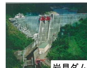
岩見ダム状況写真
