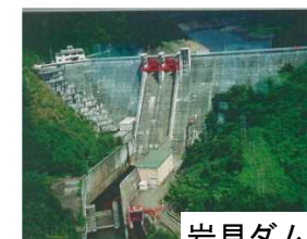
岩見ダム状況写真
