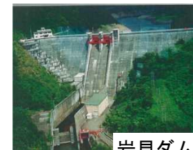
岩見ダム状況写真
