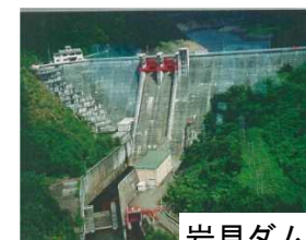
岩見ダム状況写真
