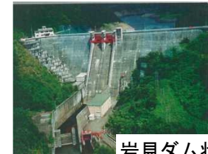
岩見ダム状況写真
