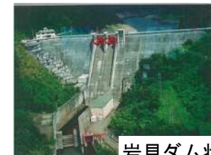
岩見ダム状況写真
