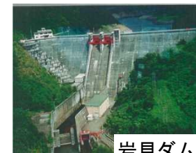
岩見ダム状況写真
