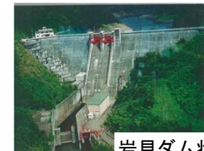
岩見ダム状況写真
