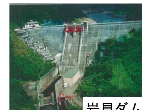
岩見ダム状況写真
