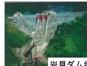
岩見ダム状況写真
