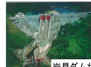
岩見ダム状況写真
